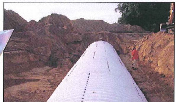
De aanleg van de duiker is inmiddels voltooid en hetzelfde geldt voor de kunststof leidingen.
