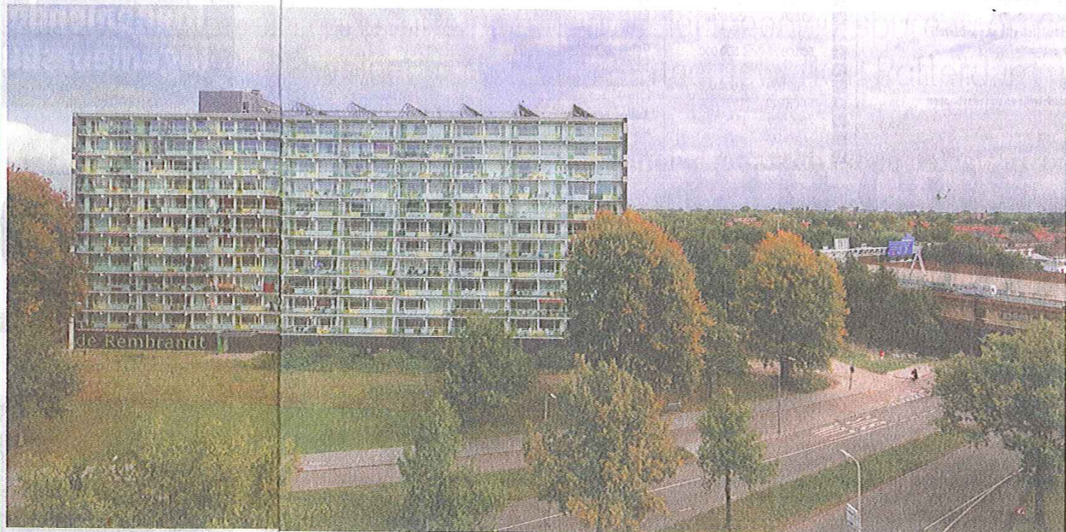
De gerenoveerde Rembrandtflat in Zwolle.
