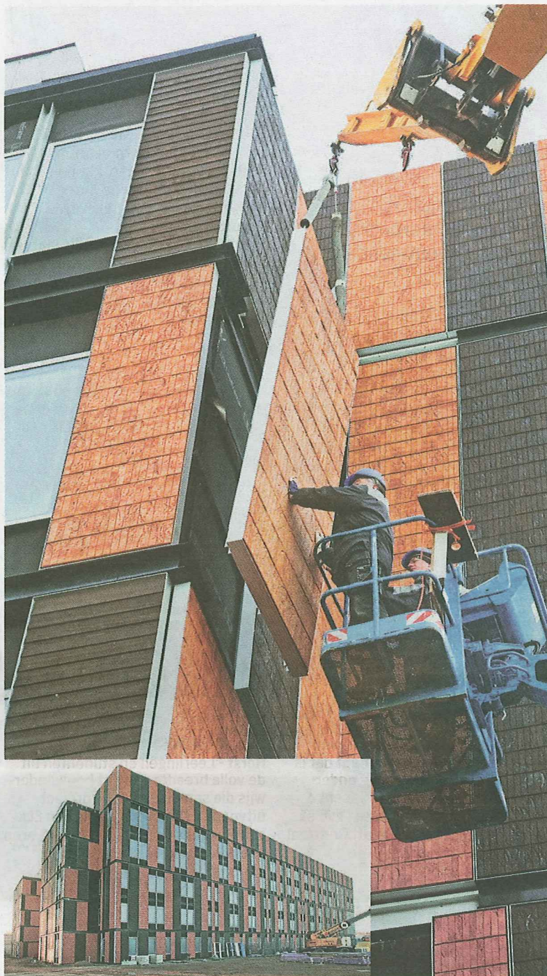
Het Gelre ziekenhuis wordt voorzien van prefab gevelsystemen. Foto: APA
