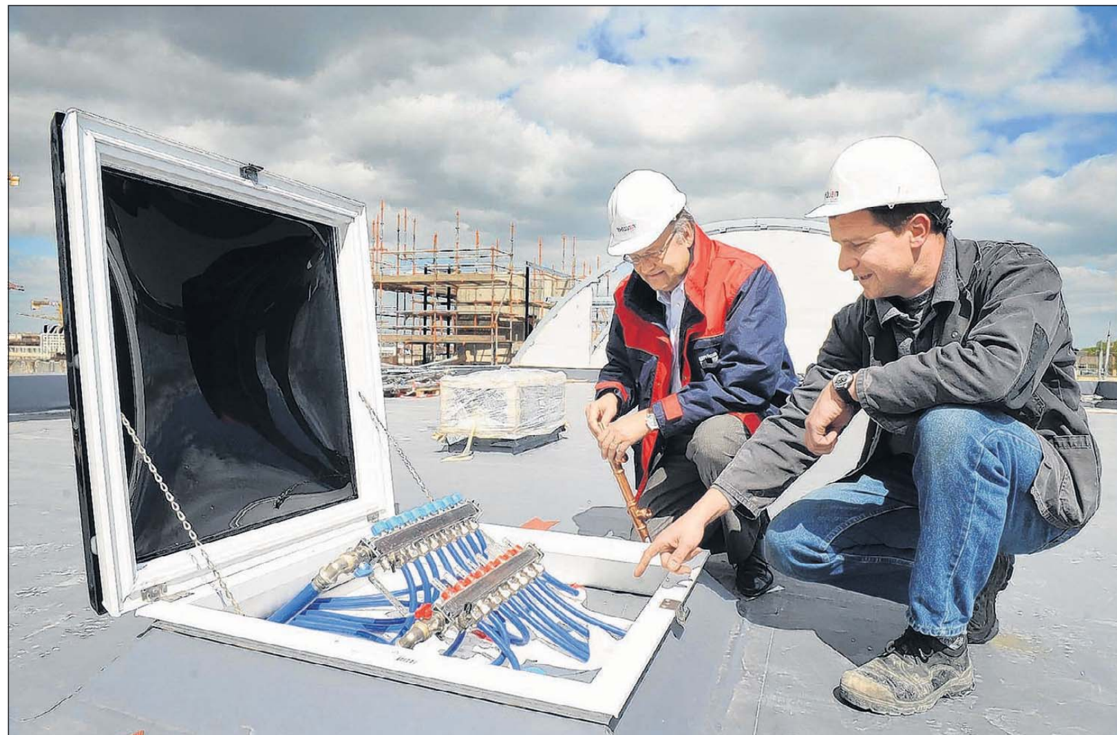
Peter Thissen (links) en Gert Jan van de Pas van Thissen Installatiebedrijf op het dak van Panta Rhei waar 'vloerverwarming' ligt.
