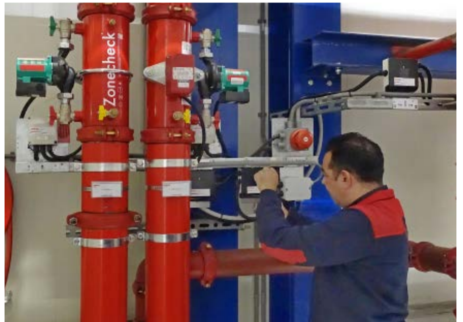
David Moniz, inbedrijfsteller brandmeld bij Unica Fire Safety, legt de laatste hand aan het Zonecheck-systeem bij Action in Zwaagdijk-Oost.
